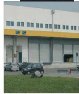
Particolare della struttura - Detail
