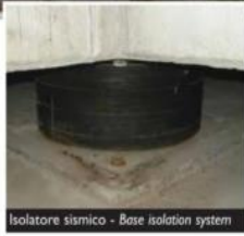
Isolatore sismico - Base isolation system
