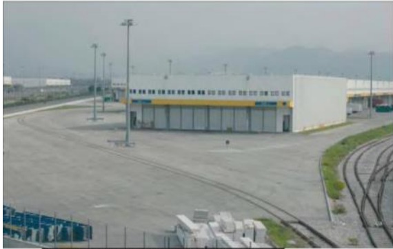
Capannoni Isola 8 (Veduta d'insieme) - Building Area 8 (Front view)
