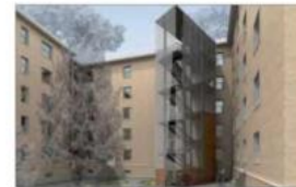
Montaggio scala di emergenza - Emergency exit
