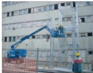
Montaggio scala di emergenza - Emergency exit
