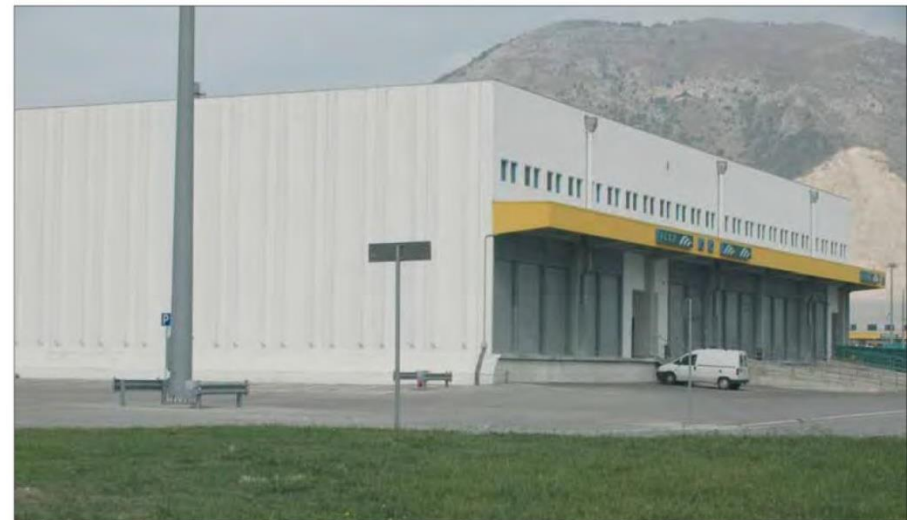
Capannone Interporto Campano - Building Interporto Campano
