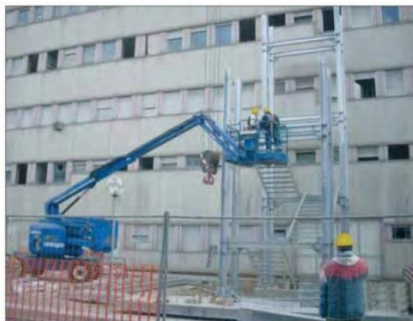
Montaggio scala di emergenza - Emergency exit
