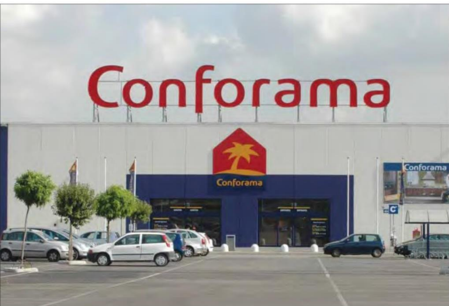
Ingresso principale della struttura - Main entrance
